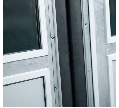
Lasimoduulit on asennettu lujille luonnollisesti hapettuneille alumiinilistoille, jotka eivät ruostu helposti.
