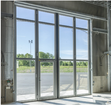
Täyslasitettu, kulkuovellinen taitto-ovi päästää optimaalisesti luonnonvaloa sisään.
